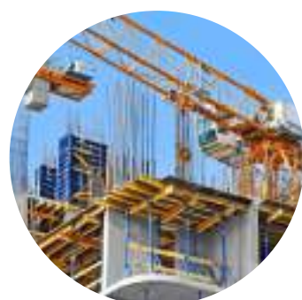
Construcción en general
