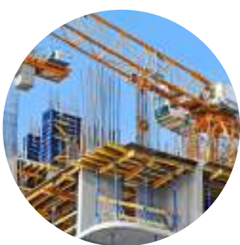
Construcción en general
